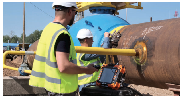
Проведение контроля кольцевого сварного соединения дефектоскопом «Альфаскан 3»
