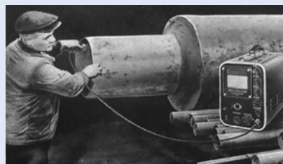
Контроль роторов, дефектоскоп Крауткремер, 1950-е годы
