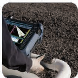
Контроль сварных швов труб малого диаметра
