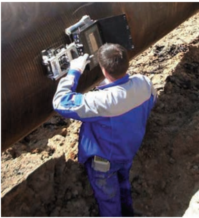
Рис. 12. Сканер-дефектоскоп УСД-60-8К-А в процессе настройки на трубу 1220 мм
