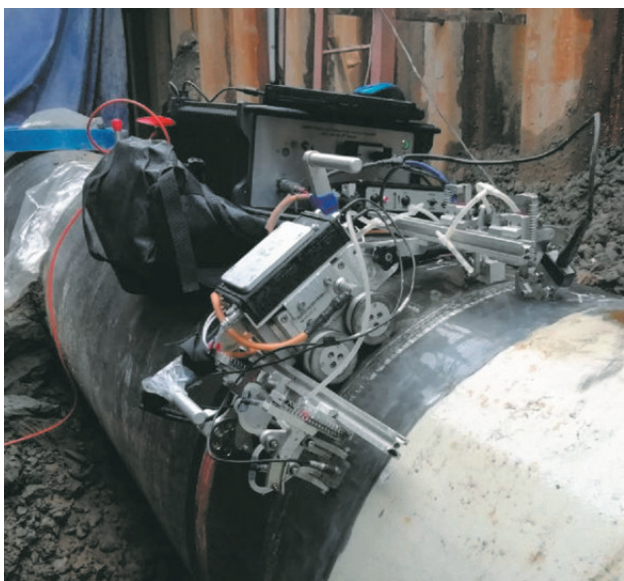
АУЗК сварного соединения диаметром 720 мм системой «АВГУР-ТФ»
