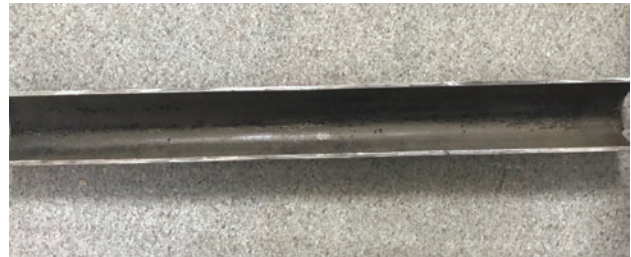
Рис. 10. Фрагмент трубы с язвенной коррозией, вырезанный из технологического трубопровода
