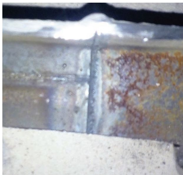
Рис. 2. Непровар фермы промышленного здания
