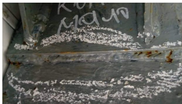
Рис. 3. Типичные дефекты металлических конструкций
